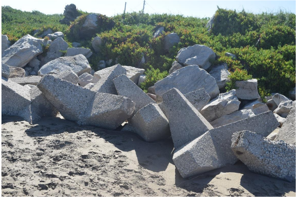
Figura 77. Tetrápodos para protección de playas en Balneario Parque Mar Chiquita en el año 2019. Se observa parte de la estructura cubierta por arena.
