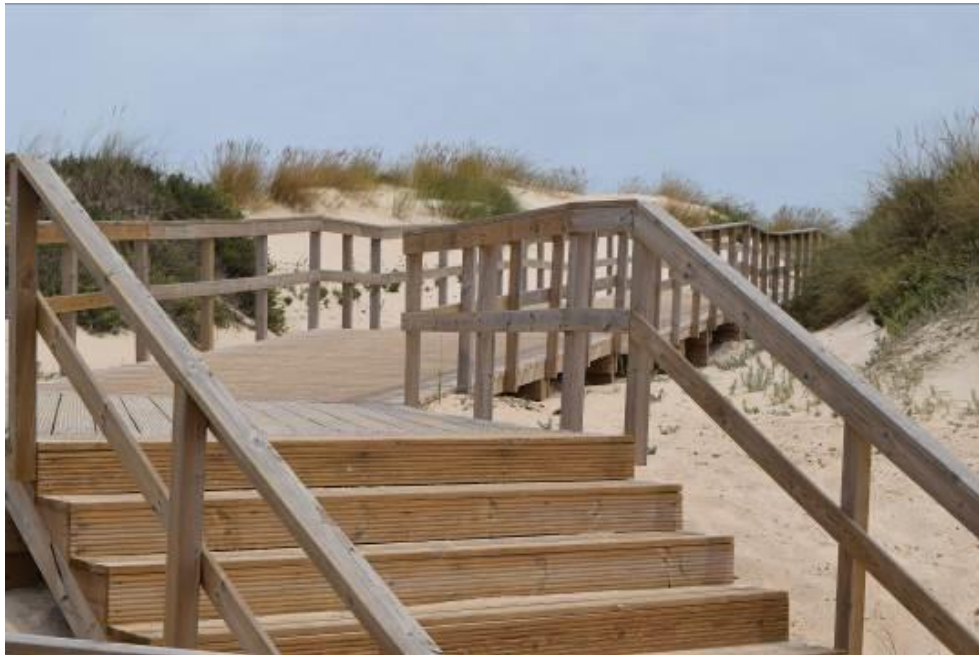
Figura 78. Accesos de playa sobre elevados atravesando el cordón de dunas frontales de manera perpendicular en Peniche, Portugal. Fuente: Archivo propio.
