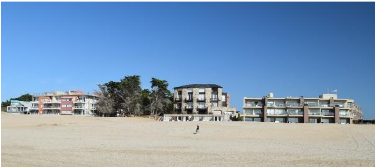
Figura 14. Cambios de uso del suelo en zonas costeras: reemplazo del cordón de dunas por coberturas urbanas en Las Gaviotas, provincia de Buenos Aires. Fuente: archivo propio.
