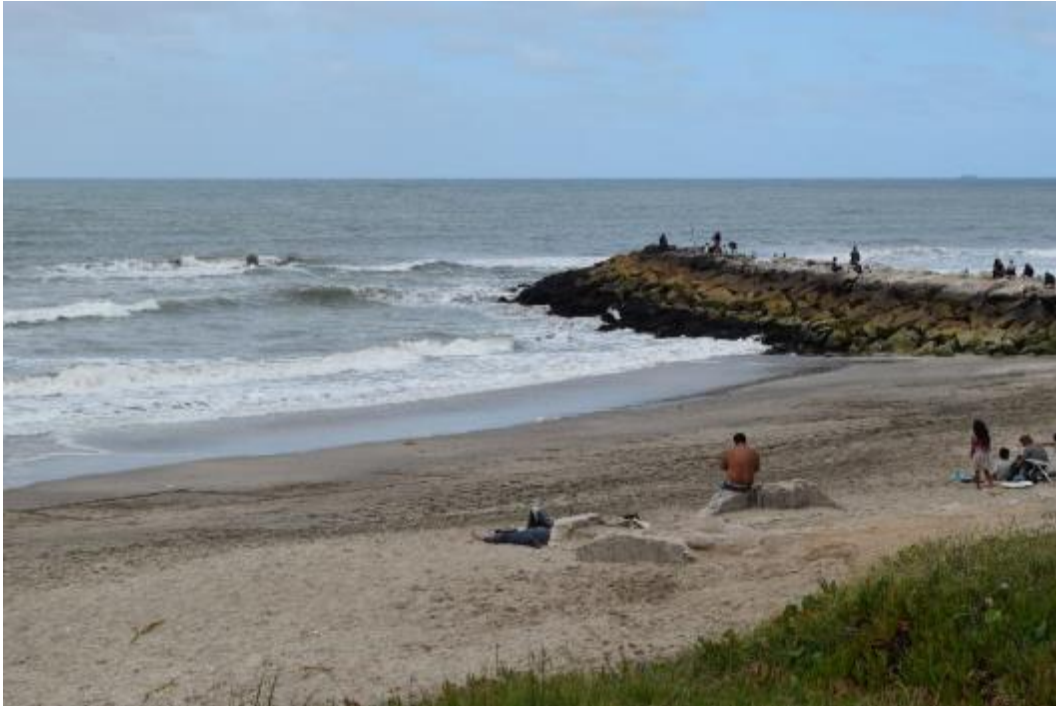
Figura 52. Escollera ubicada en el sector norte de Miramar, Partido de General Alvarado.
