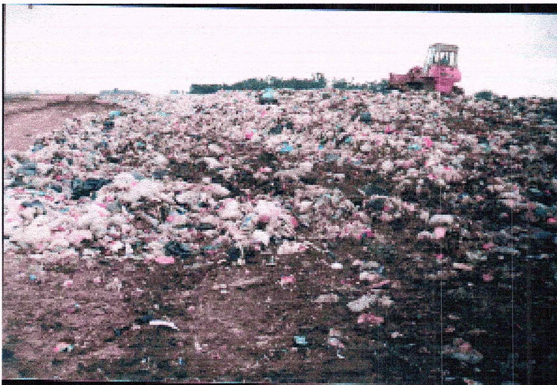
Máquina aplastando la basura en la celda I.
