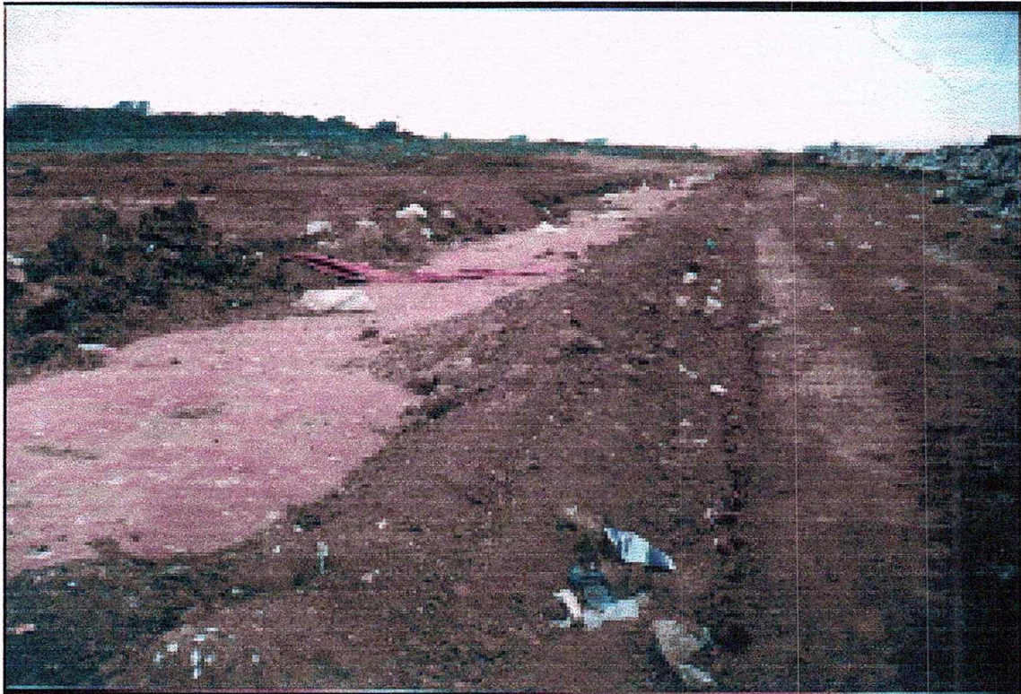
Celda II terminada, prolongaciones para celda III.
