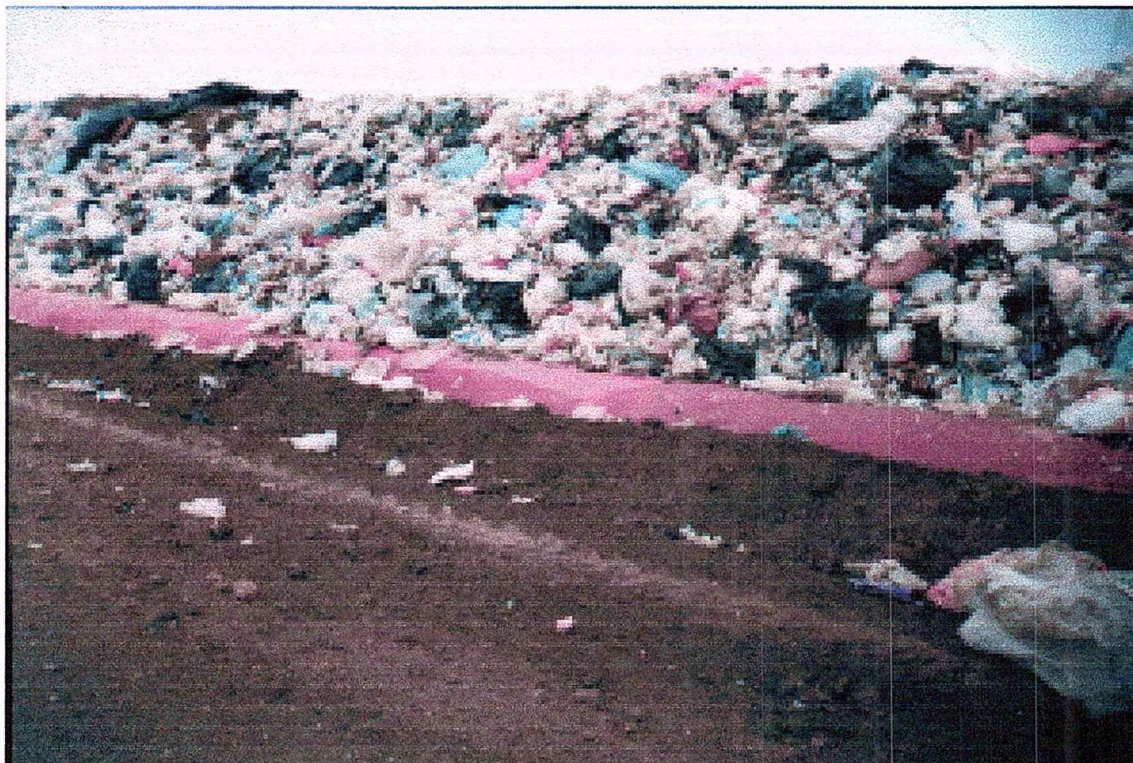
Celda I, excedida al no realizarse la tapada diaria.
