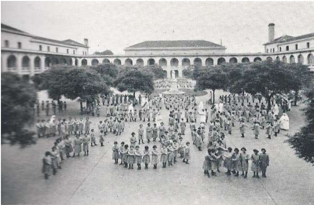
Foto N° 444. Las alumnas en el espléndido patio que rodea la casa.
