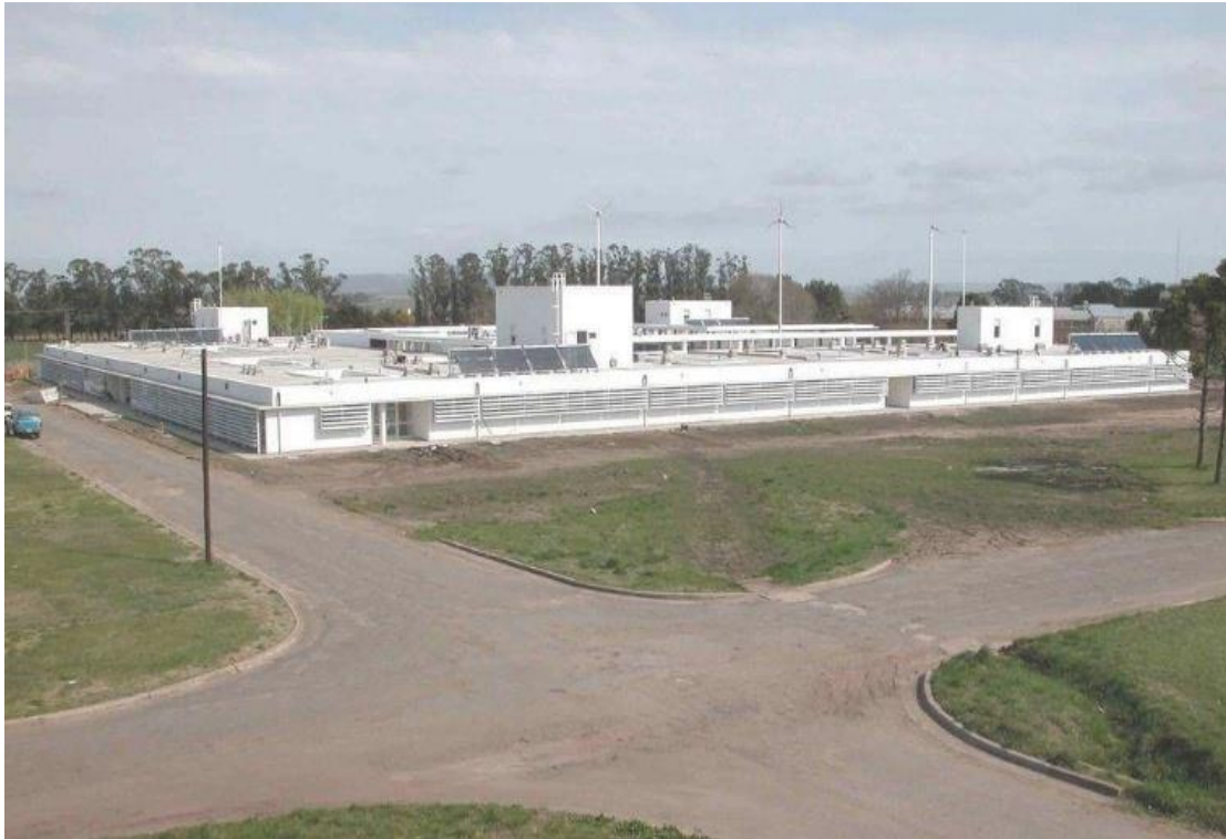
Figura 5. Edificio del Área de Investigación Agronomía de la EEA INTA Balcarce.
