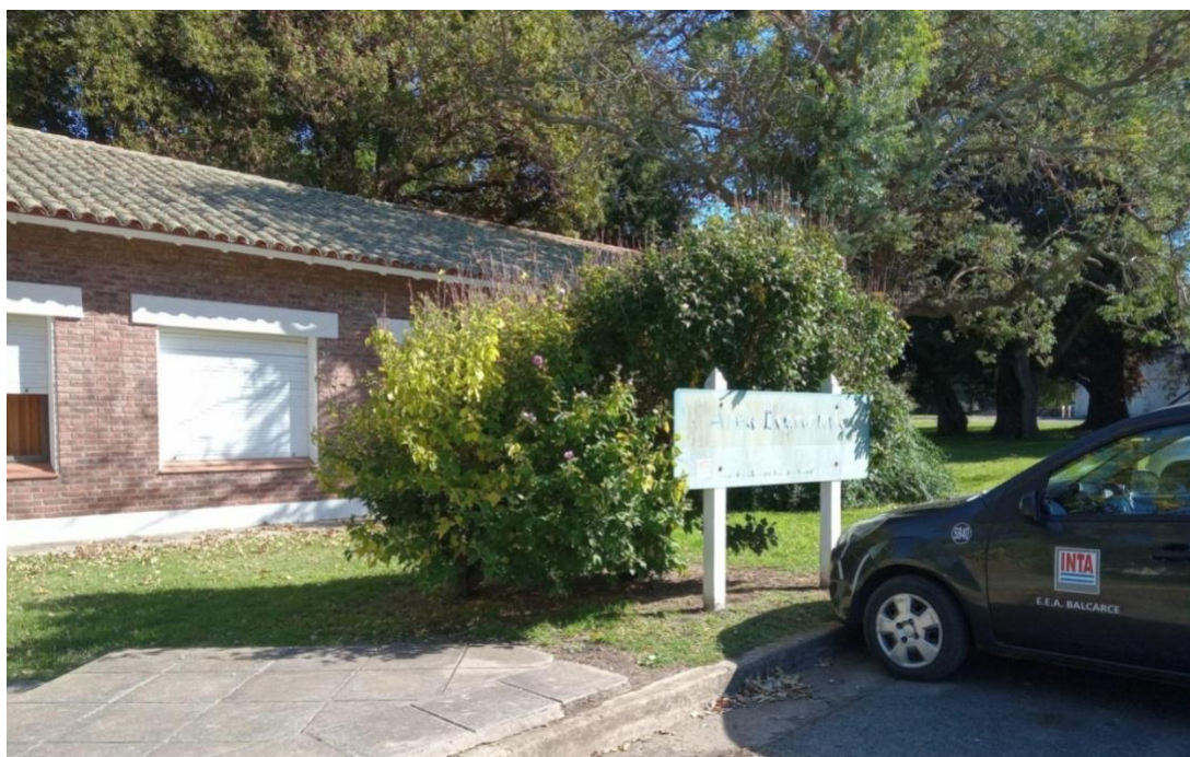
Figura 6. Edificio del Área de Investigación Economía y Sociología Rural de la EEA INTA Balcarce. Fuente: fotografía de la autora.
