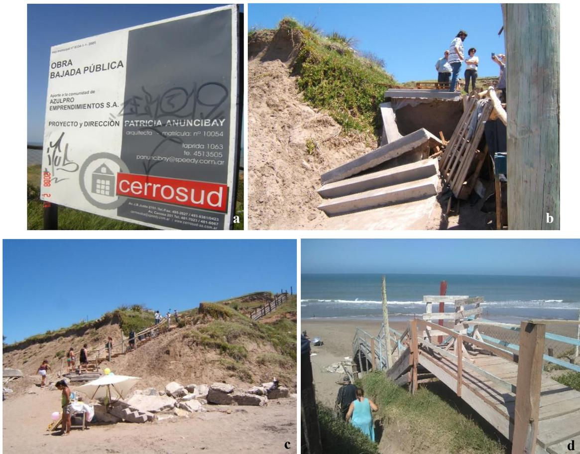
**Figura 8.13. a) Unificación de los pasos F y G a cargo de Azul Pro, 2008 – deterioro de la escalera: b) 2010 - c) 2015 - d) 2021.**
