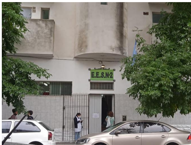
Foto 1: fachada de EES N°2. Año 2021.
