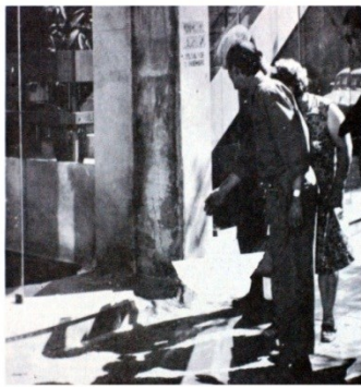
Vecinos observan los daños en la fachada del edificio de la Caja Cooperativa de Crédito Bahiense producidos por una bomba colocada por la Triple A el 26 de enero de 1974. Fuente: La Nueva Provincia
