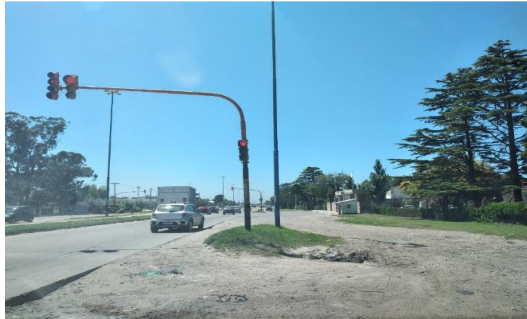
Foto 4 Vista INAREPS y entorno
