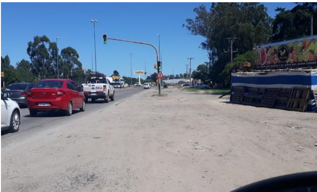
Ruta 88/ Av. Centenario. Tránsito y banquina
