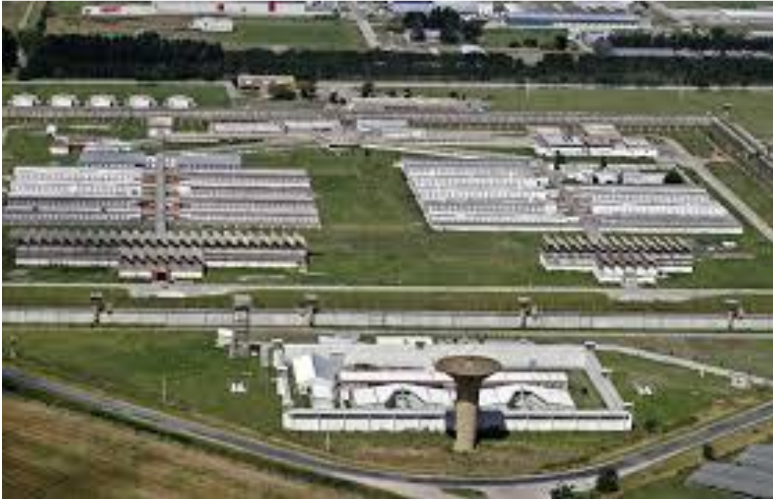
Vista aérea de Unidad Penitenciaria Batán
