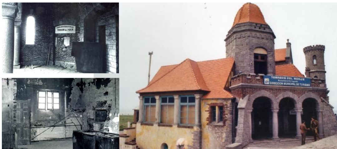
Foto 29. El Torreón del Monje: antes y después de su reintegro al municipio
